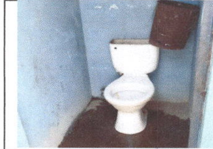
FOTO 2: Sustitución de piso de cemento líquido por piso ceramico Y Sustitucion de Azulejo EN BAÑOS
