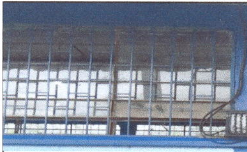
FOTO 5: Mantenimiento a balcones de metal
