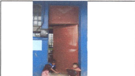
FOTO 9: Fabricación e instalación de puertas de metal en módulos
