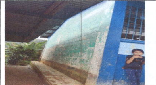
FOTO 8: Pintura en muros exteriores e interiores
