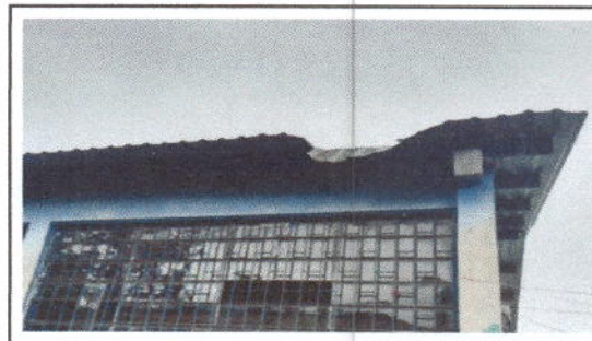
FOTO 4: Sustitución de lámina, por lámina troquelada aluzinc calibre 25
