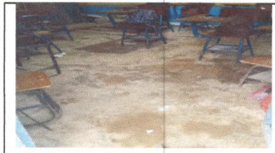
FOTO 6: Sustitución de piso de cemento líquido piso ceramico
